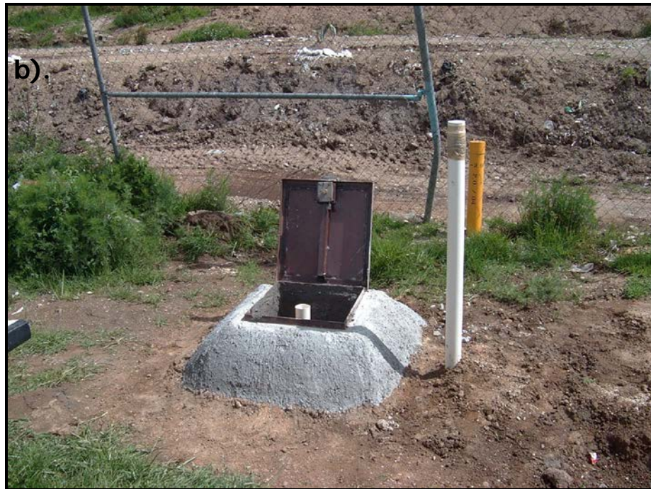
Figura 4.9. Construcción de los pozos de observación (serie PO's). a). Trabajos de perforación con perforadora mecánica marca Wacker; b). Terminación y protección de pozos.
