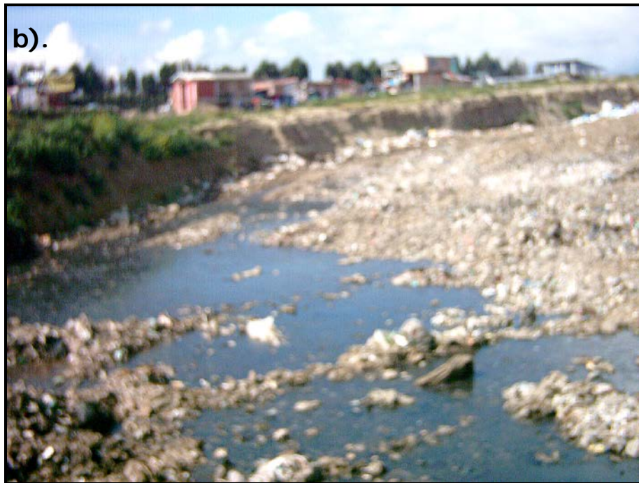
Figura 6.3 a). Fuga de lixiviado dada en los bordes laterales del vertedero presentando acumulación excesiva de lixiviado; b). Fuga ocurrente en la base del vertedero, generando acarreo de basura y probable infiltración a zonas laterales y subyacentes.
